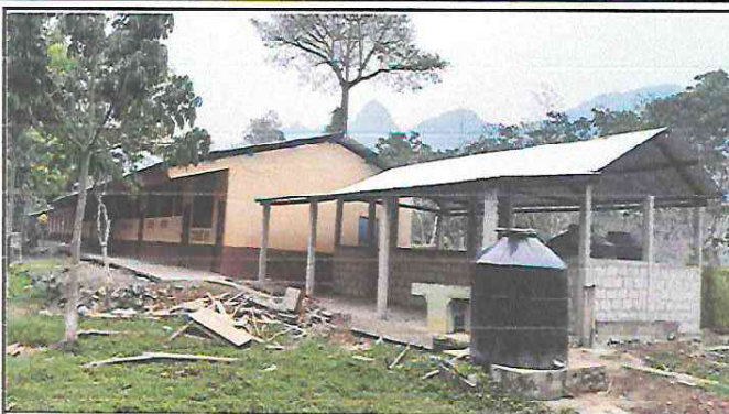
Foto 2: Se Observa la cocina terminado.
