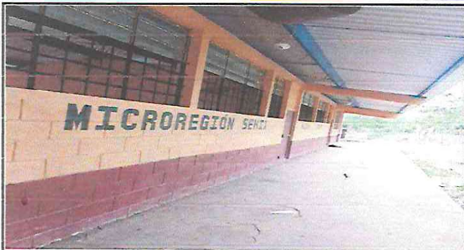
Foto 1: Se observa las ventanas con balcones ya instaladas
